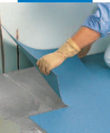
Lægning af ledende PVC med Ultrabond Eco V4 SP Conductive
