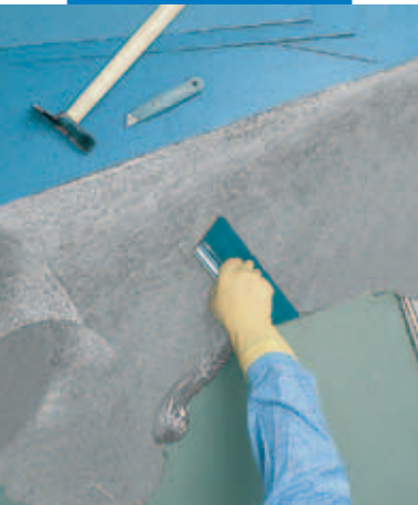
Påføring af Ultrabond Eco V4 SP Conductive
